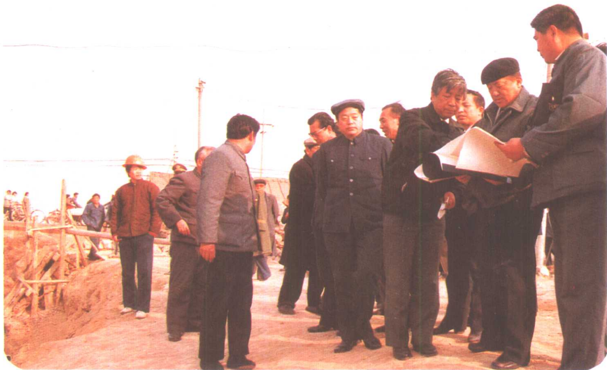
交通部长钱永昌视察沙颍河沈丘船闸工地
