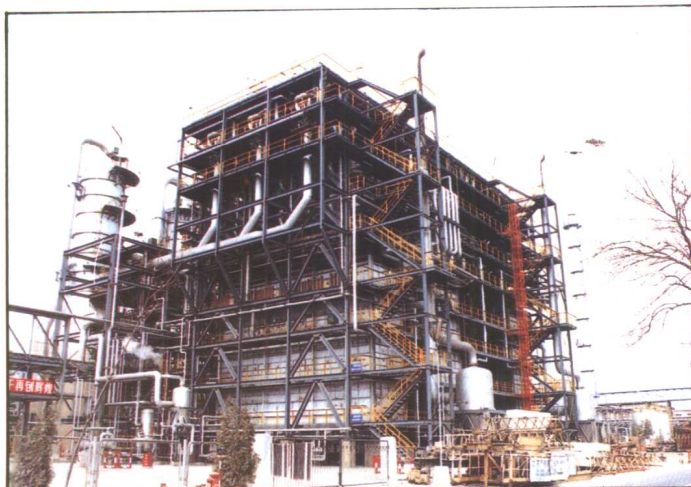
建行北京燕化专业支行 20 多年来先后拨、贷款 64 亿元，支持北京燕山石化公司生产和建设。图为燕化公司化工一厂裂解炉。
