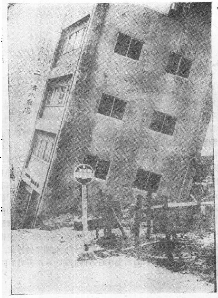
一幢发生倾斜和下沉的建筑物——1964年日本新潟地震时 土层液化的后果之一
