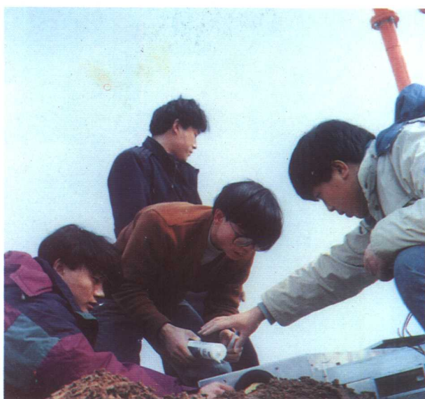
安装向塘机场盲降设备
