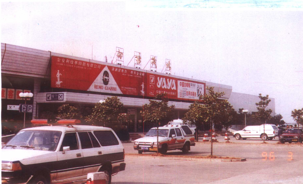
1992 年 5 月竣工启用的 向塘机场候机联检大楼
