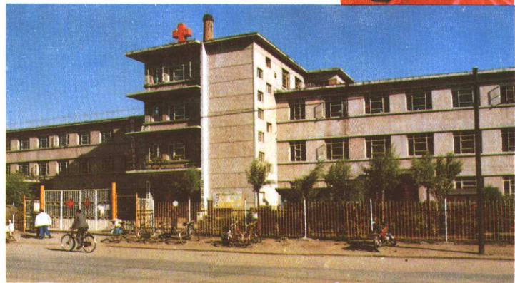
县人民医院主楼
