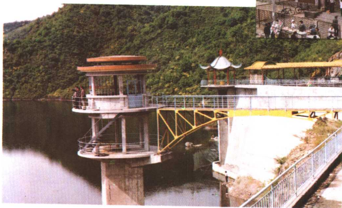
县小孤家水库
