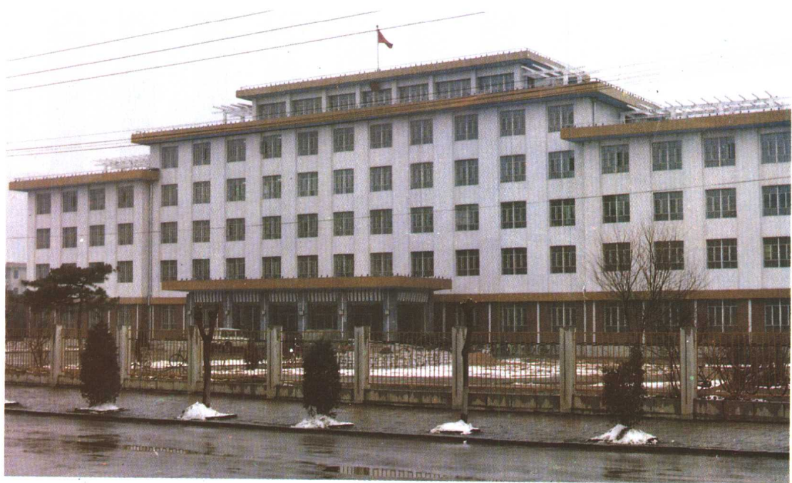
清原县人民政府办公楼
