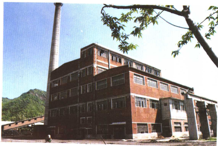
县热电厂厂房
