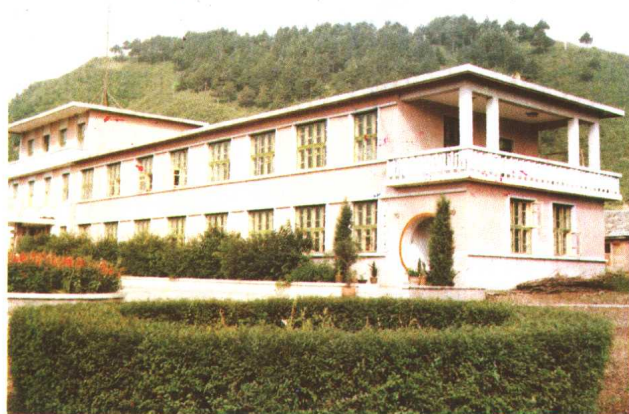
北三家林场办公楼
