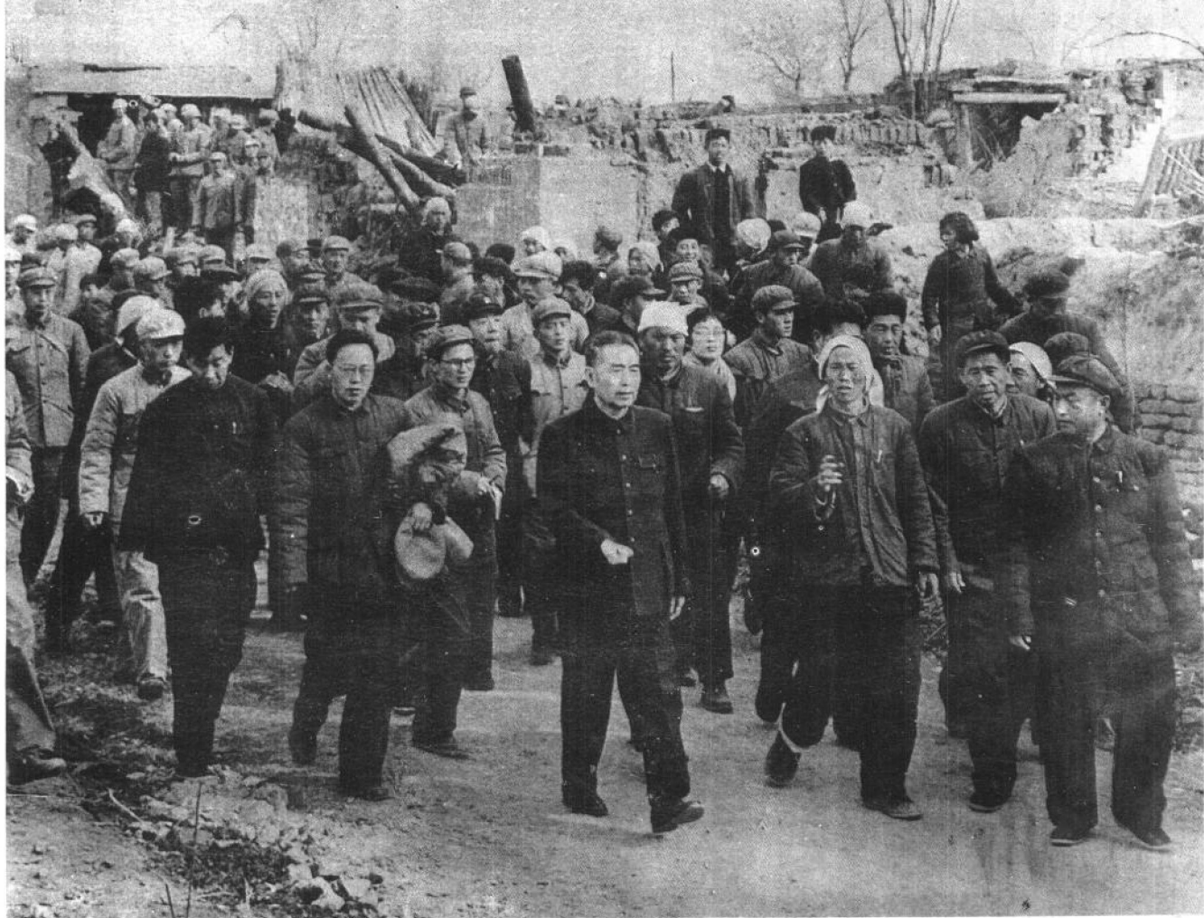
照片 1.2 3月10日周总理视察隆尧县白家寨公社白家寨大队，并在慰问灾区人民大会上讲话，勉励大家“自力更生，奋发图强，发展生产，重建家园”。
