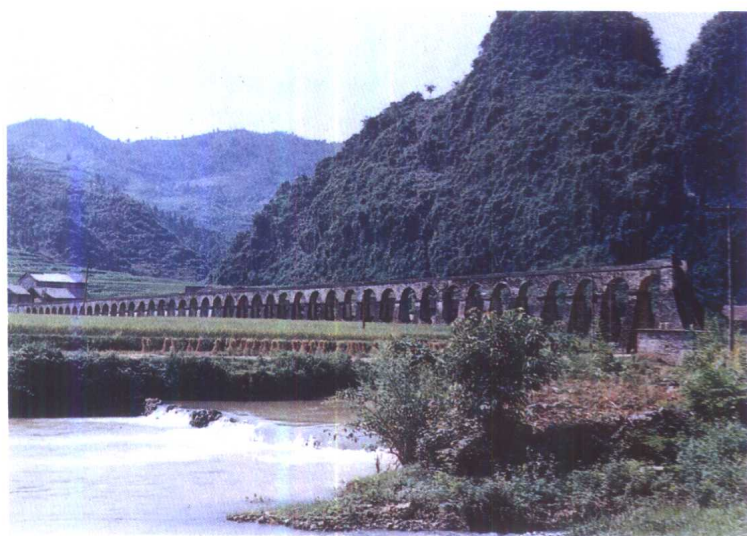
岷暮乡桥头引水渡槽
