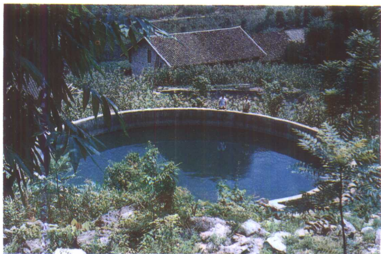
石山地区群众用“以工代赈”资金修建的蓄水柜
