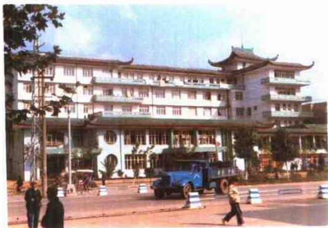
珠珊第二建筑队的建筑质量 全区最优——图为该队建筑的新 余市中医院门诊大楼
