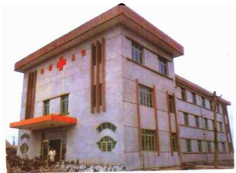
1986年新建的珠珊卫生院门诊大楼
