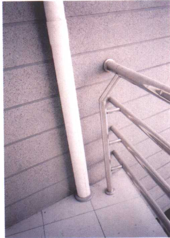
(b) 落水管穿越阳台板
