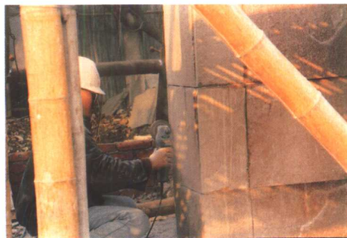
(e) 贴毛石后用砂轮修缝使缝宽 整齐一律
