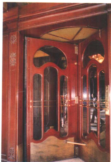
(f) 某木制转门中间有铰链、 搭钩，可改变开启方式
