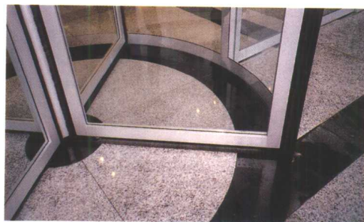
(g) 不锈钢转门门扇四周有挡风刷
