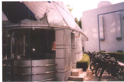
(h) 金属面板间用硅胶嵌缝
