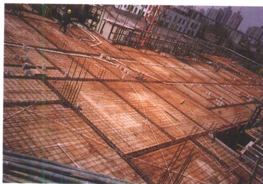
(d) 完成钢筋工程
