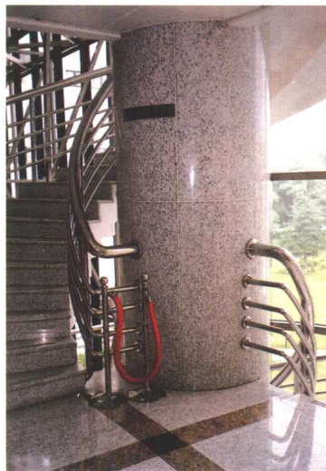
(g) 水平栏杆杆件终端的固定
