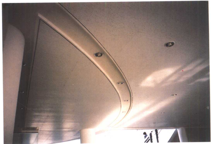
(e) 矿棉板作密缝处理，板面孔洞的尺度较大，模糊了“缝”的存在
