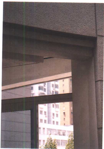
(b) 砂胶在转角处作出仿石材的厚度
