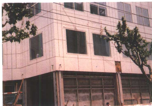
(g) 金属幕墙转角处为折角板
