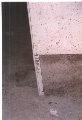
(c) 贴面砖在阳角处可用阳角条处理
