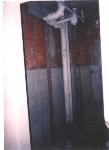
(c) 上、下水管穿越卫生间楼板
