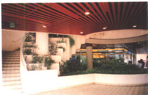
(b) 铝合金吊顶条板作扇形布置
