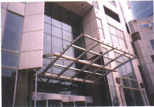
(f) 大门用金属板包门套为了掩盖立管
