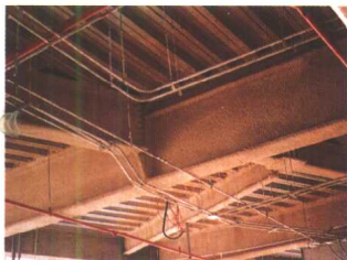
(a) 钢结构底喷涂防火材料
