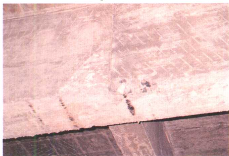
(a) 现浇钢砼脱模后如表面光滑应先 凿毛后粉刷
