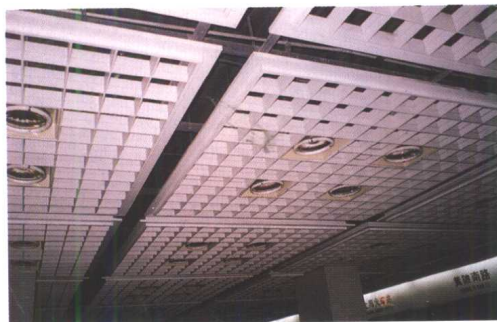
(c) 铝合金吊顶组成单元式格构构件重复使用
