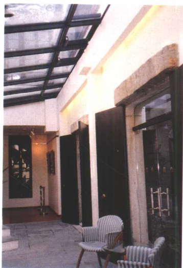
(e) 立轴式实木板门 及无框玻璃门
