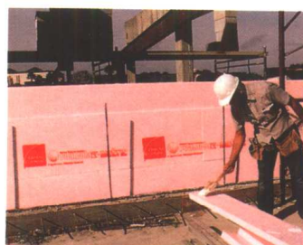
(h) 高分子发泡材料 可以粘贴
