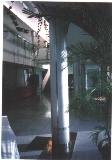
(e) 塑铝板包圆柱，不锈钢条盖缝
