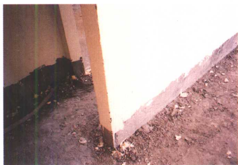
(b) 墙、地面粉刷分工序进行
