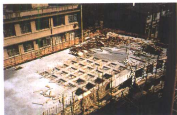
(d) 钢筋混凝土楼面
