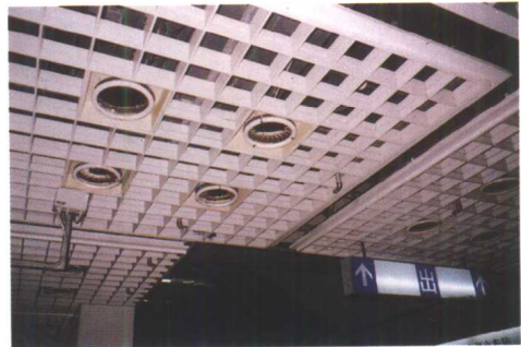
(e) 吊顶上方走水、电等管道
