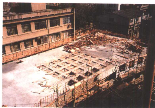
(g) 脱模后的现浇钢砼楼板
