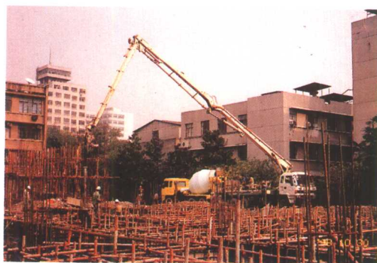
(f) 用商品混凝土整体浇注
