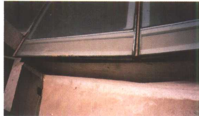
(b) 结构胶(玻璃底部)和密封胶(玻璃间)
