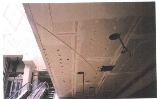
(g) 石膏板缝间先做嵌缝处理，并贴上盖缝带
