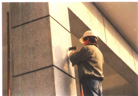
(d) 斩假石施工现场
