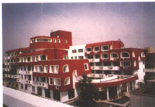
(f) 斜墙面仿“梦厦”屋顶处理
