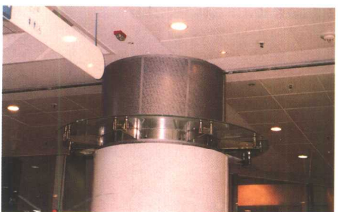
(h) 不同质感的金属面板分段包柱子, 玻璃装修节点与该建筑的幕墙用同样连接手法
