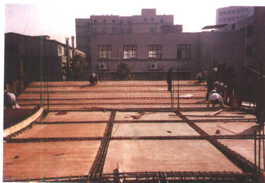
(c) 梁、柱钢筋连通, 开始布板筋
