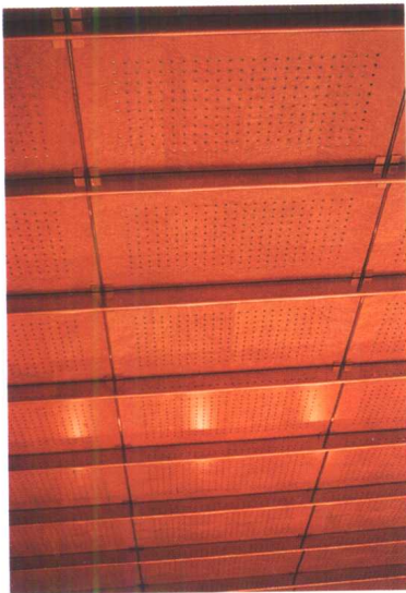
(a) 穿孔金属板吊顶
