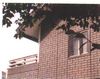
(a) 加气混凝土外墙板
