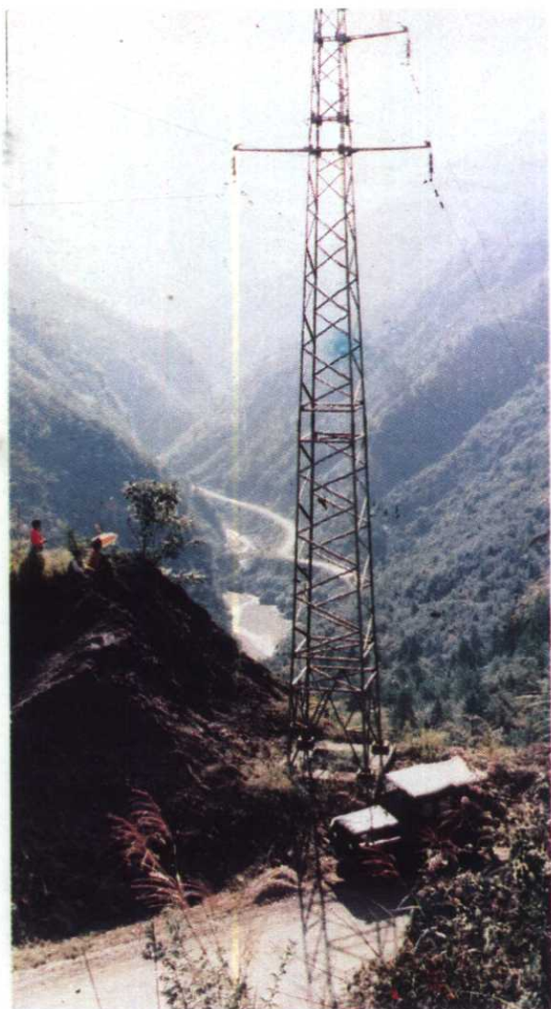
三肩坡铁塔(田开桓 摄)
