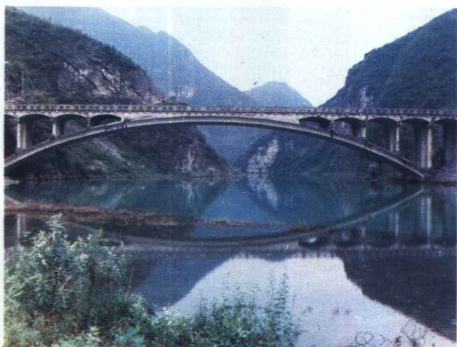
偏岩公路大桥
