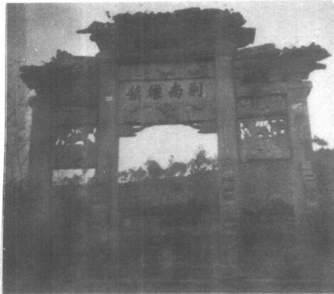
座落在尖山的明代土司皇城，地震时，房屋倒塌，石牌坊尚存，但牌坊顶部的石花雕被震脱榫，石柱的石雕构件错位
