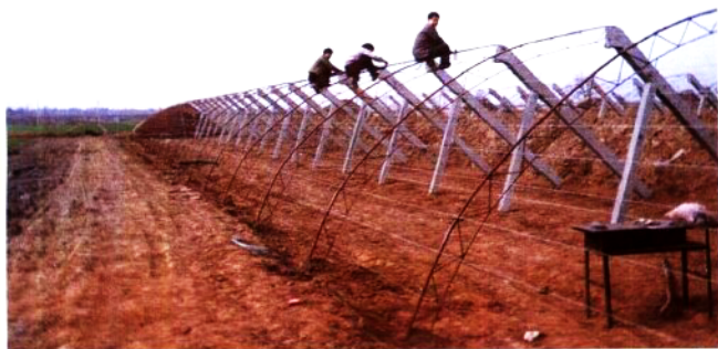
鸟翼型长后坡无 后墙越冬专用温 室骨架结构
