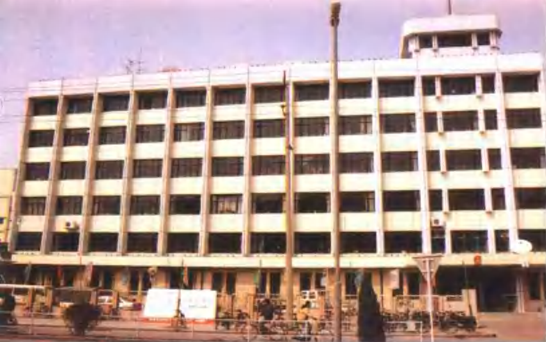
河北区人民政府大楼
