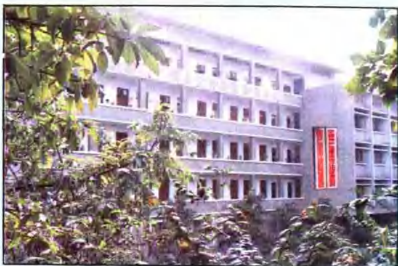
► 中共江北区委大楼
