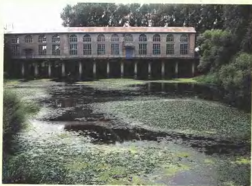
黑鱼沟排水站
