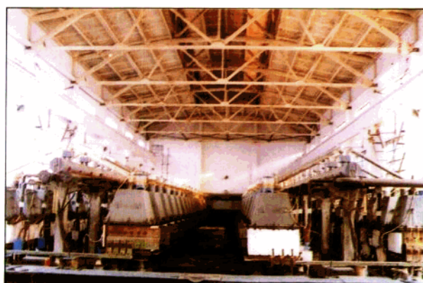
南阳石油化工厂 烧碱车间
