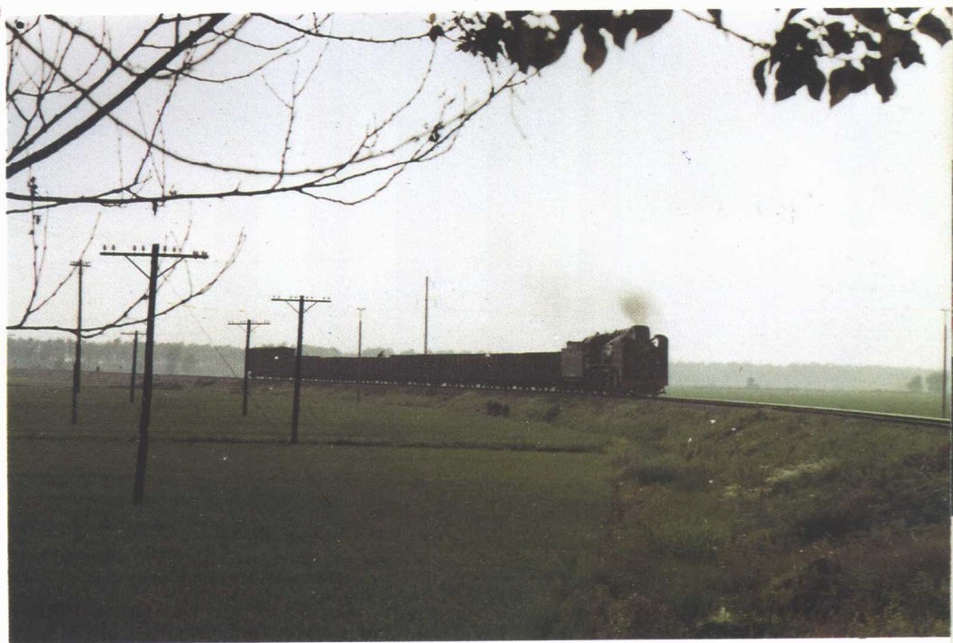
▷ 大东港至丹东铁路专用线
