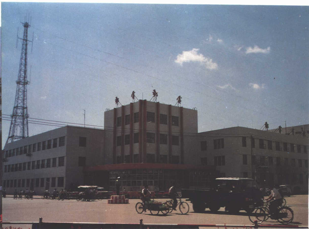
△ 东沟县邮电大楼
