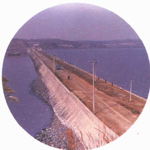
△ 金坑拦海大坝
