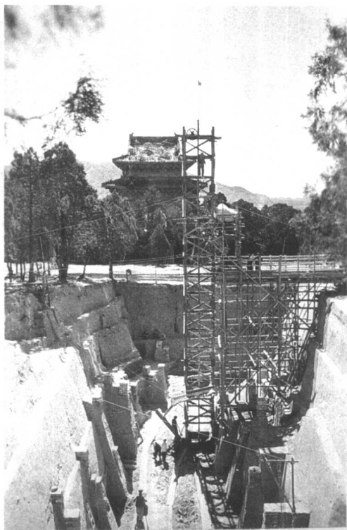
开挖第三探沟。
