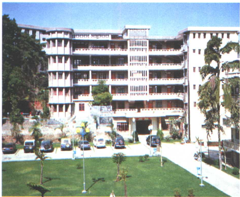
富宁县人民政府办公楼, 1984 年建。
