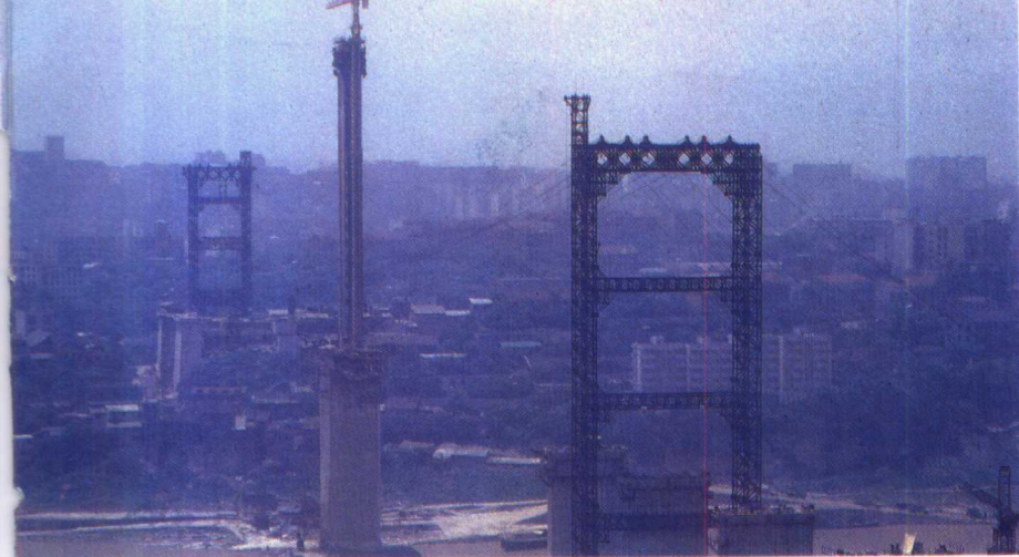
建设中的嘉陵江石门大桥
