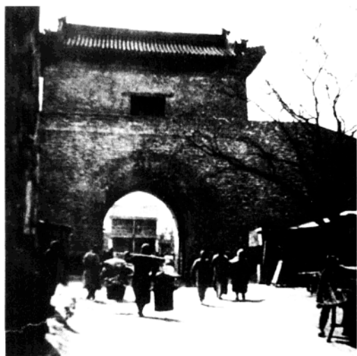
图一 永定门瓮城内景，自北向南拍摄
