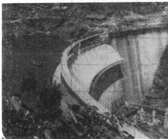
照片 1-2-2 四川省长沙砌石拱坝
