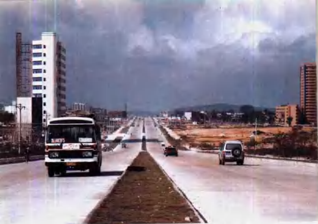
建设中的市区中心——中兴大街
