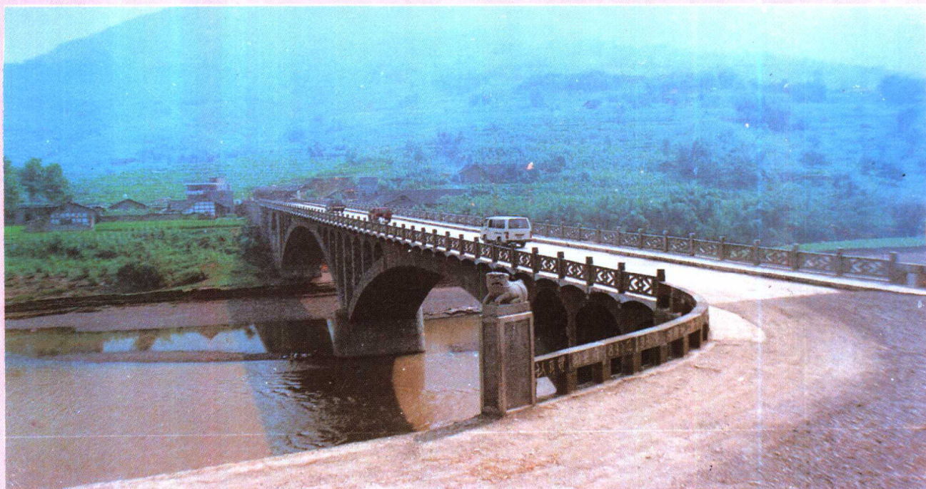
• 中低档工业品以工代赈修建的珙县腾达公路桥。
