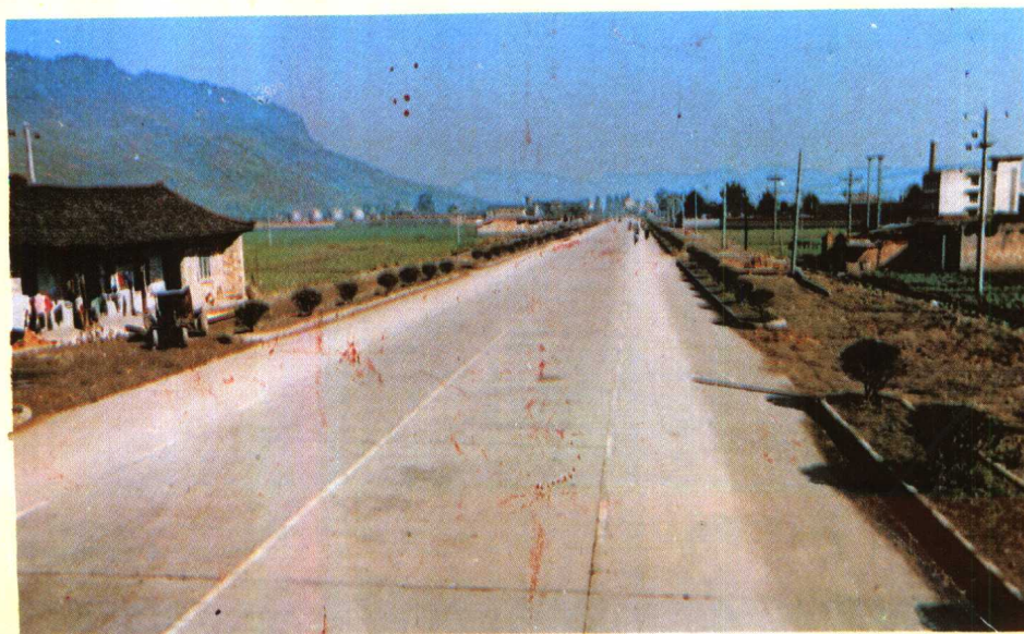
万元。 雅安地区交通局 供稿 • 雅安市进出口公路雅安—姚桥，每公里投资 45
