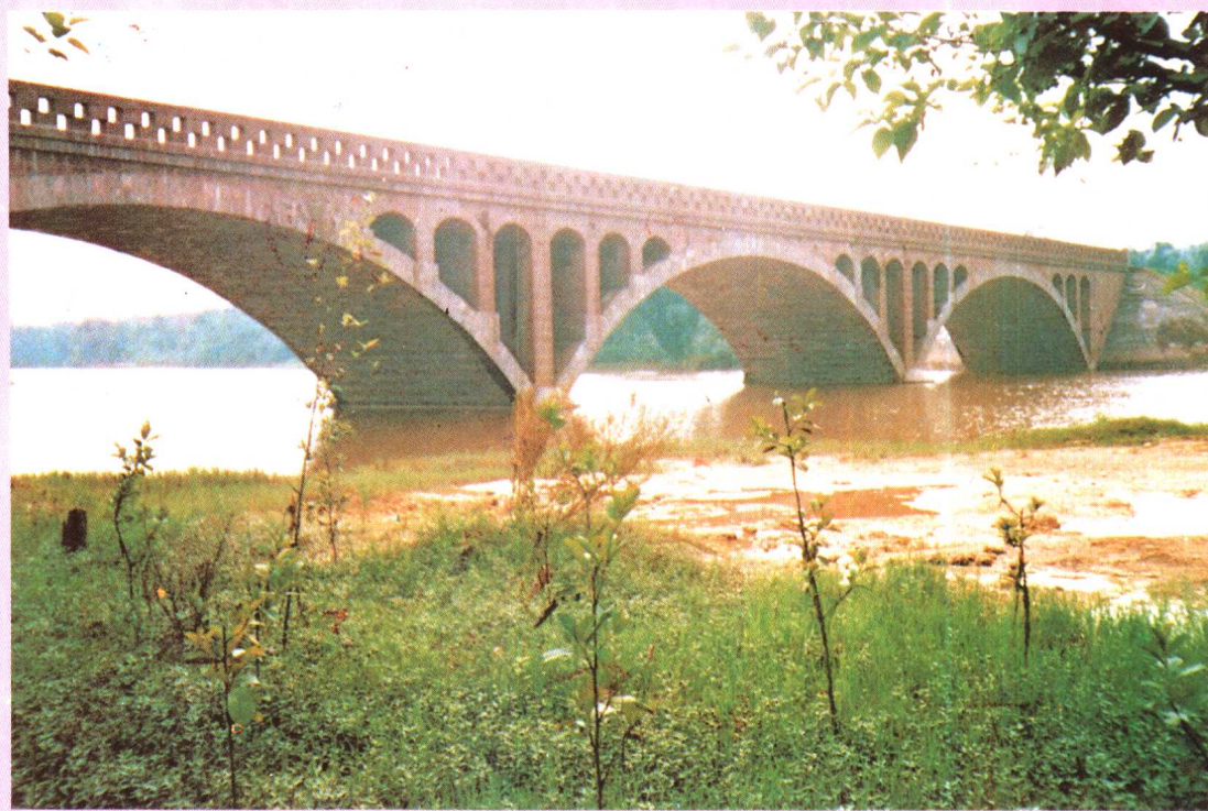
• 用世界银行贷款修建的“三一九工程”龙台大桥竣工。 方望丘 摄
