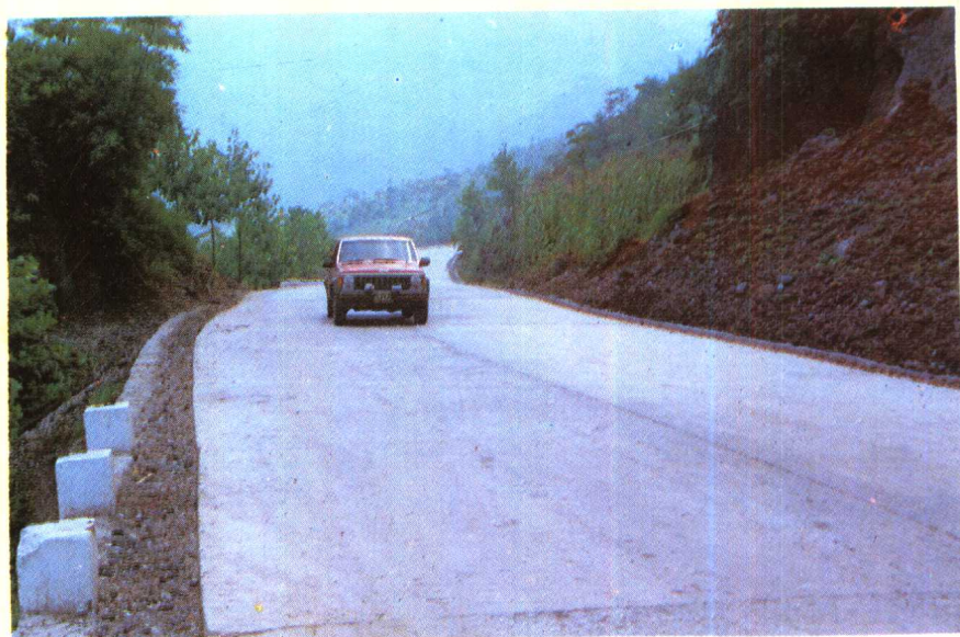
• 宜珙公路珙县至巡场路段，改建为水泥路面，大大提高了通过能力。 袁洪宝 摄
