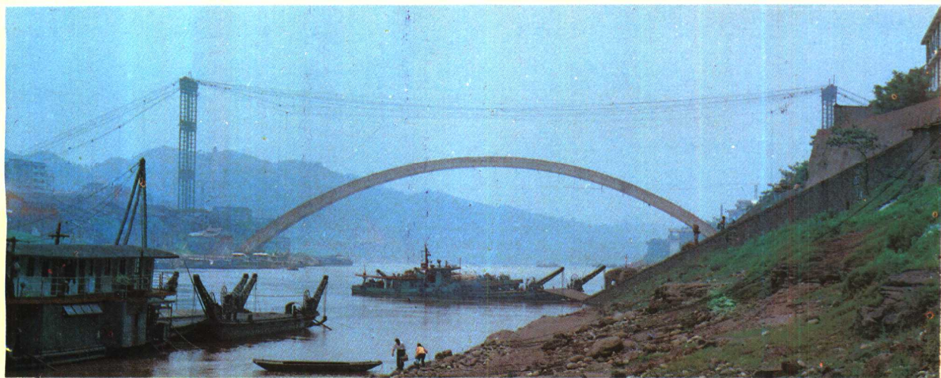
• 正在建设中的宜宾市区金沙江大桥。 徐绍曾 摄
