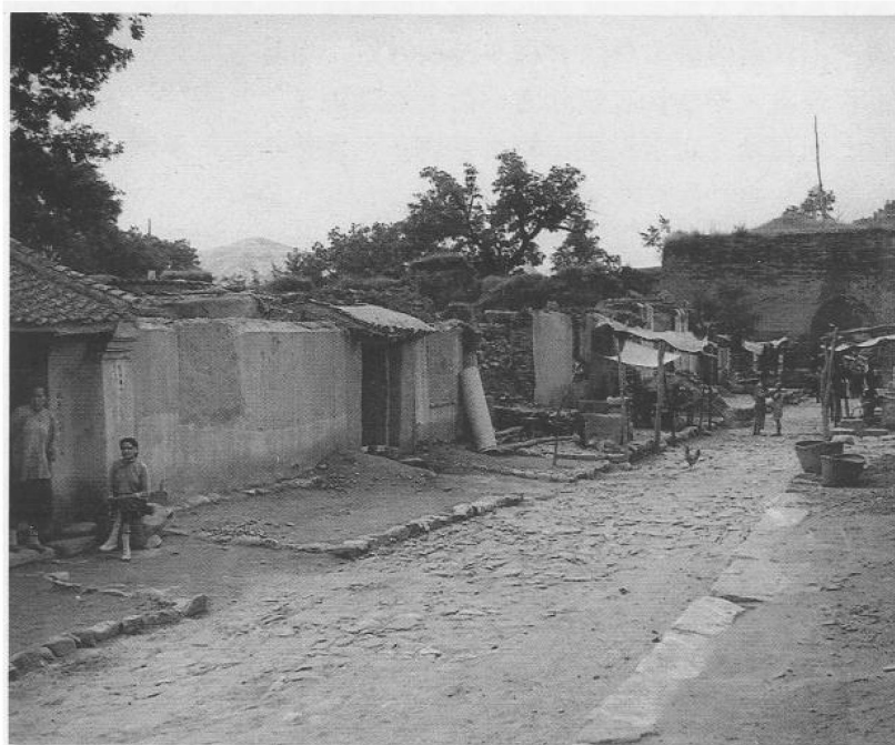
日寇在阜平烧毁的房屋（1938年）
