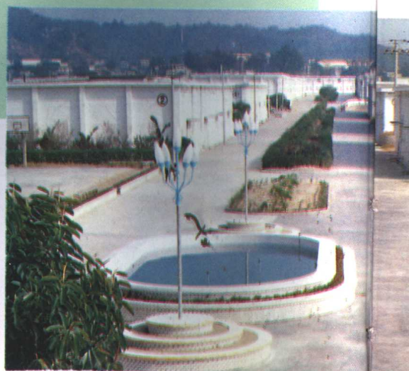
泉州市高型平顶粮库
