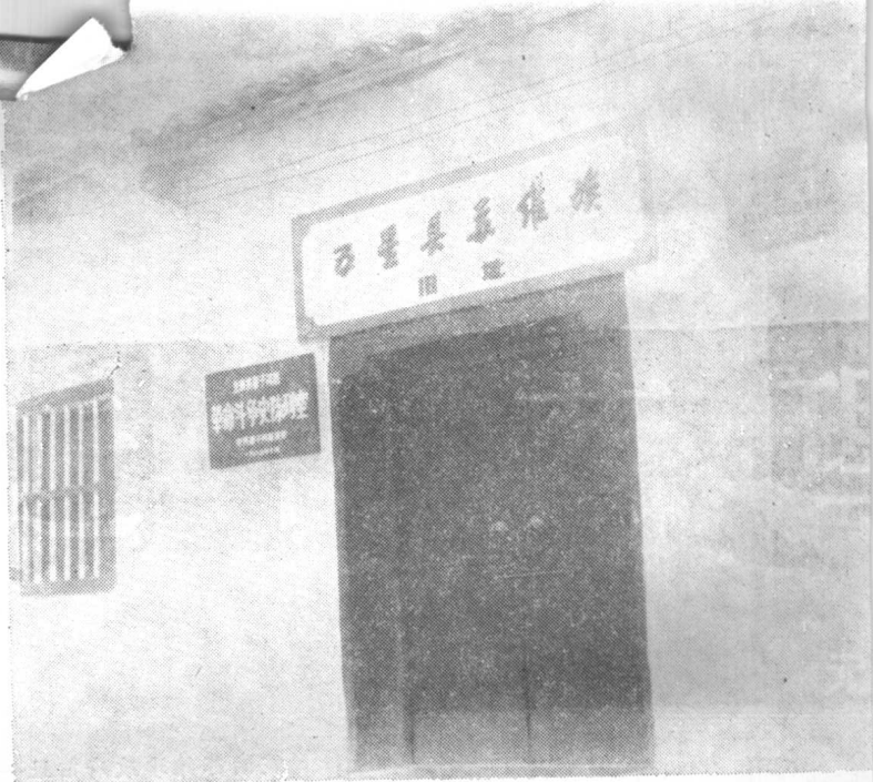
皖西北苏区五星县苏维埃政府旧址
