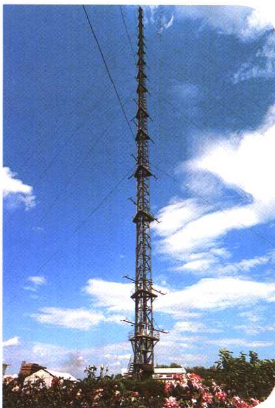
中国科学院大气所建325米高气象铁塔
