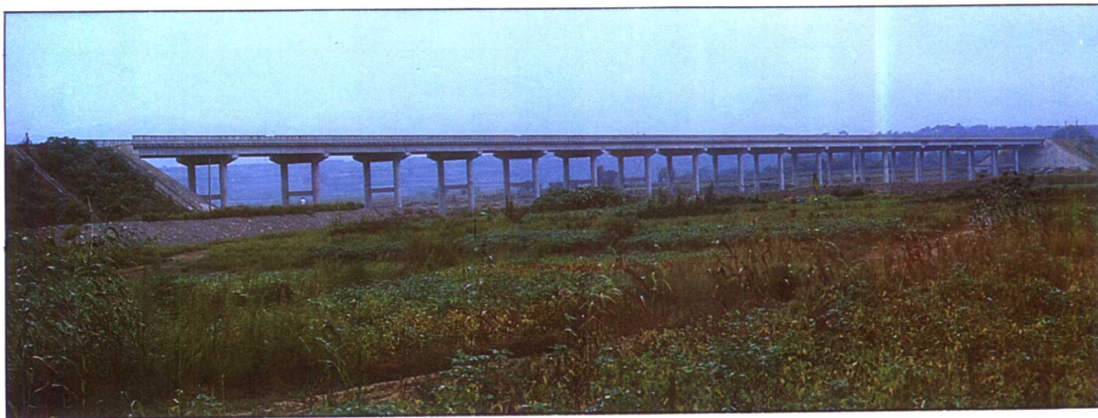
午偏公路固镇大桥
