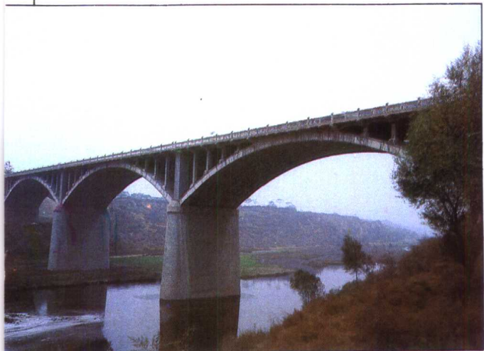
邯武复线清化大桥
