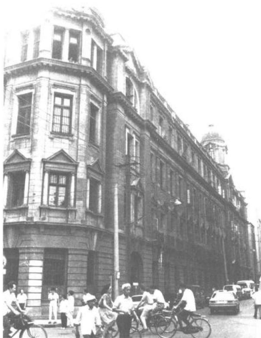
上海中国银行成立时和总管理处1935—1937年办公楼旧址
