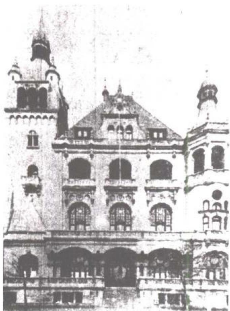
中国银行总管理处1928—1935年在上海的办公楼(1935年后被拆除)
