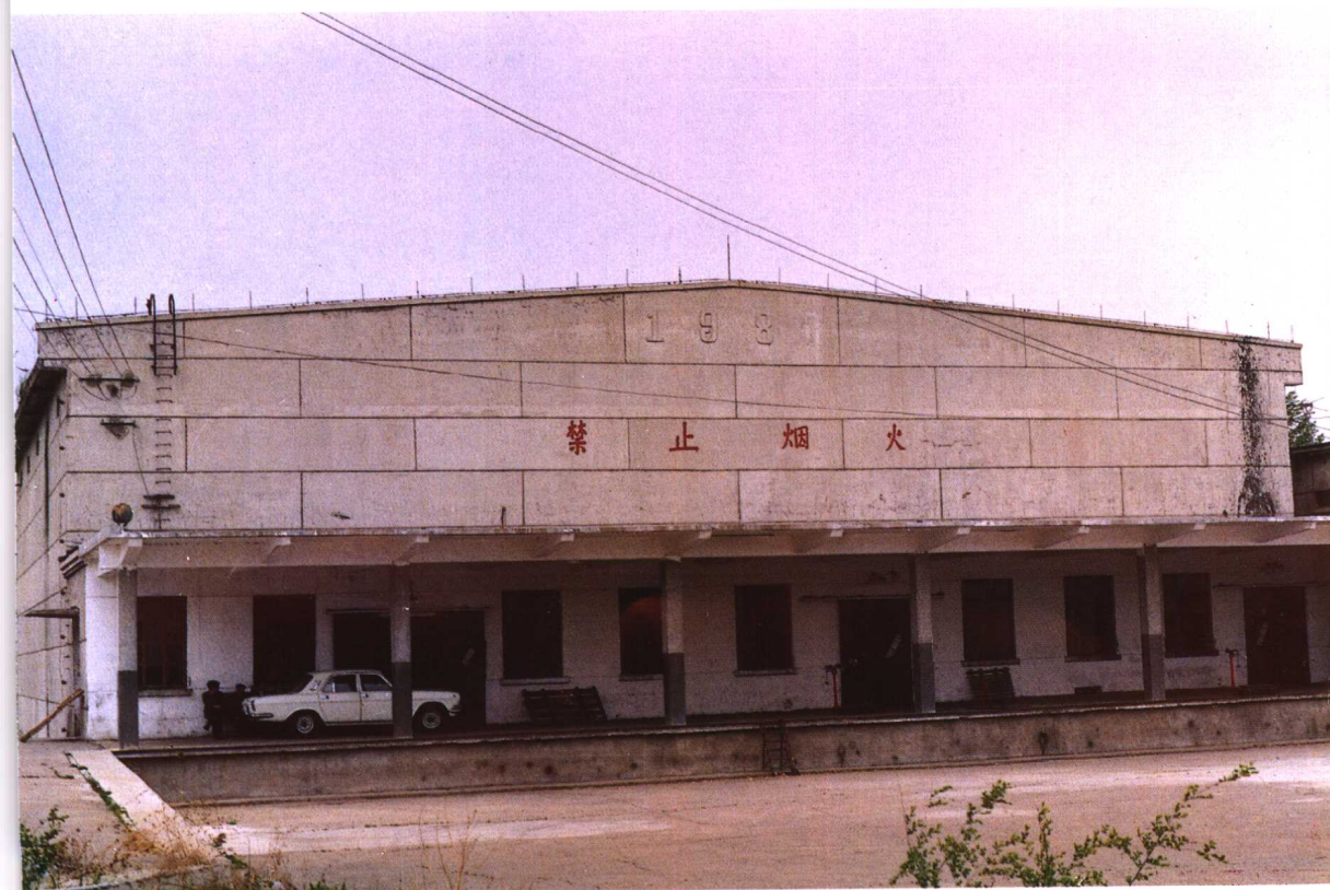
省水产供销公司 3000 吨位冷库
