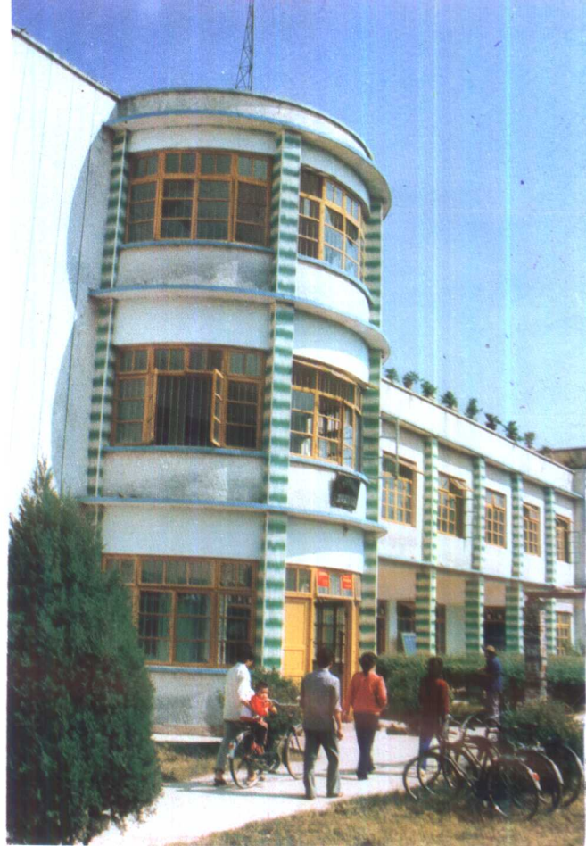
▲ 县图书馆大楼
