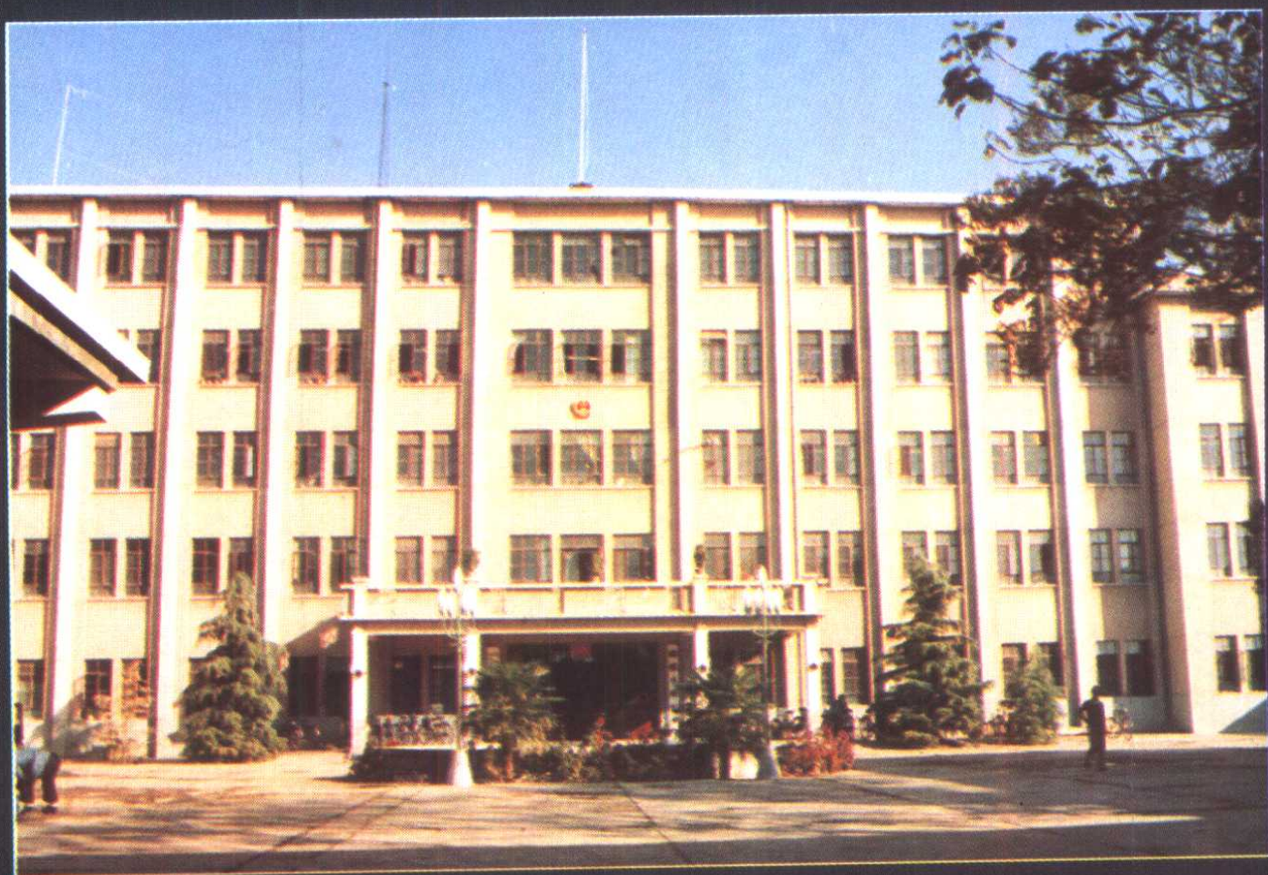
郟县人民政府办公大楼
