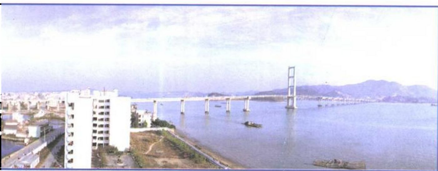
南海市九江大桥
