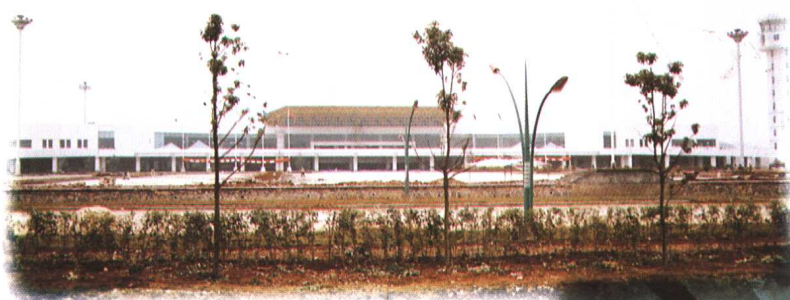
新建中的贵阳龙洞堡 机场候机大楼、航管大楼外 景
