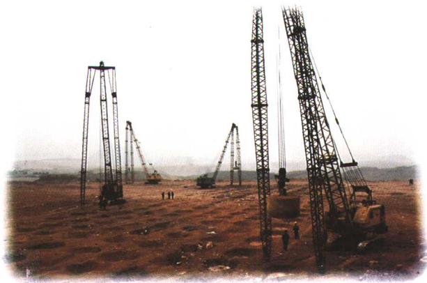
施工中填实部分进行强夯
