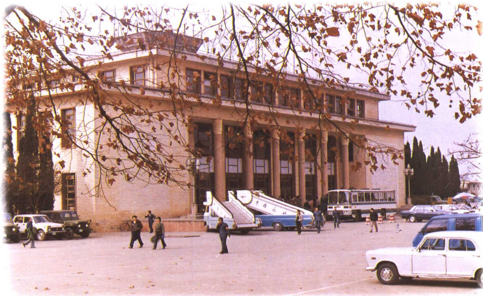
60年代建成的磊庄机场候机楼(东面)
