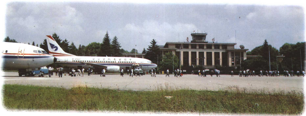
60 年代建成的磊庄机场候机楼、停机坪(西面)
