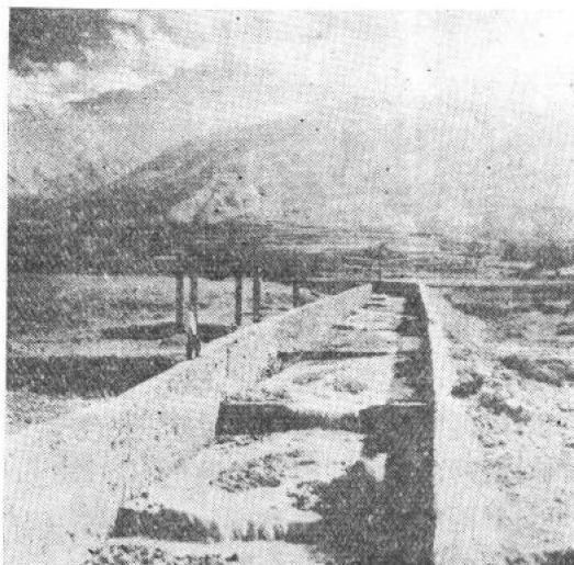
照片6 东川田坝干沟排洪道助板结构(康志成摄)
