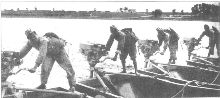
▲工程兵在黄河进行结合漕渡门桥和架设浮桥试验性演习。
