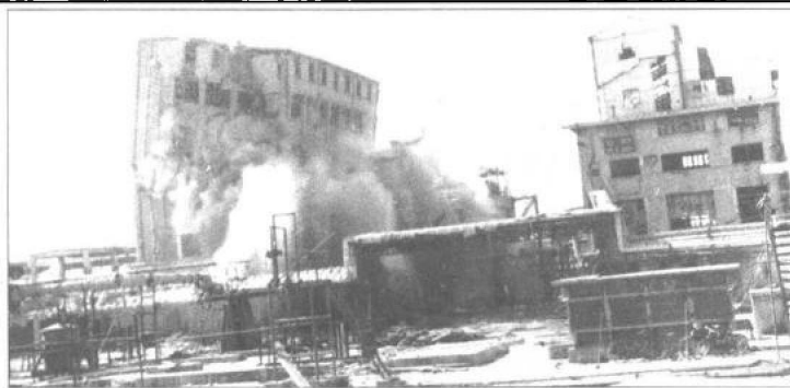
◀工程兵科研一所为江阴化肥厂控制爆破了一座40米高的楼房，倒塌方向堆积物在6米以内。
