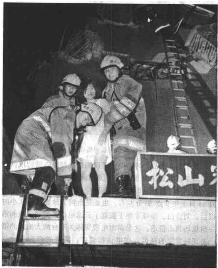
松山宾馆倒塌，消防员将生还者救离现场。
