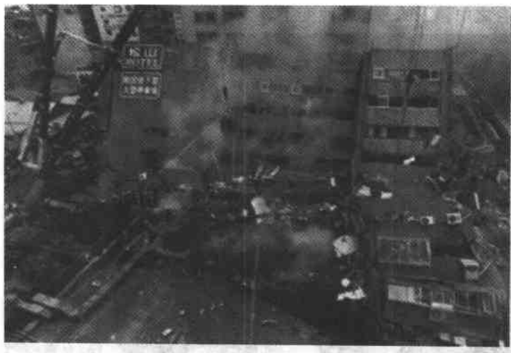
台北：松山宾馆倒塌现场。
