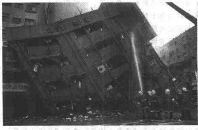
消防员在扑救台北北部新庄一幢住宅因地震倒塌引起的大火。
