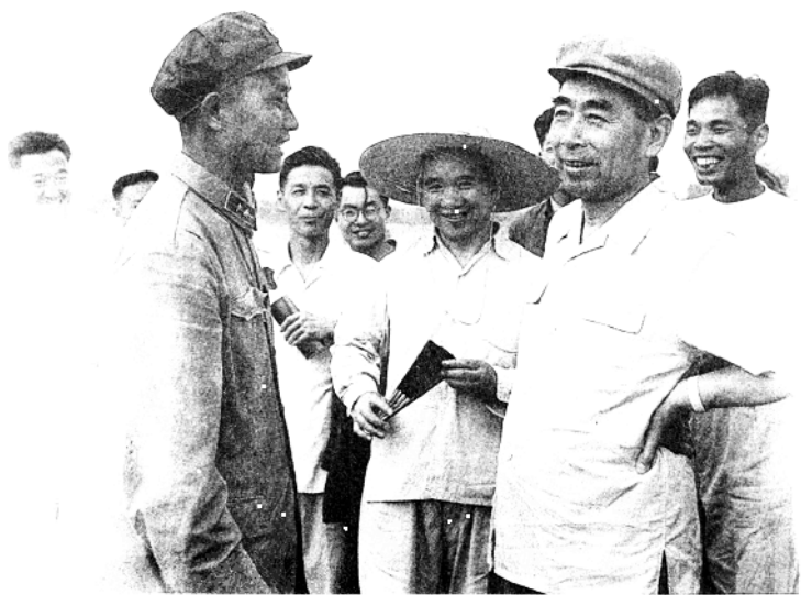
1959年，林铁同志陪同周恩来总理视察岗南水库修建工程。
