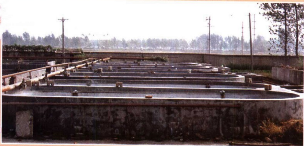
规格为 10 米 \times 3 米 \times 1.4 米的矩圆形并联式鱼池
