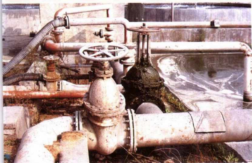
温流水鱼池总 进水控制阀
