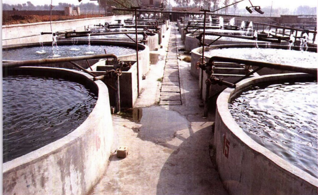
切线式进水使池水形成旋流
