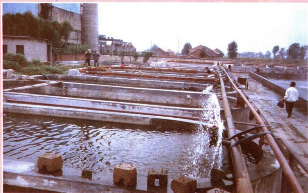
矩圆形温流水鱼池冷、暖、热三管进水系统
