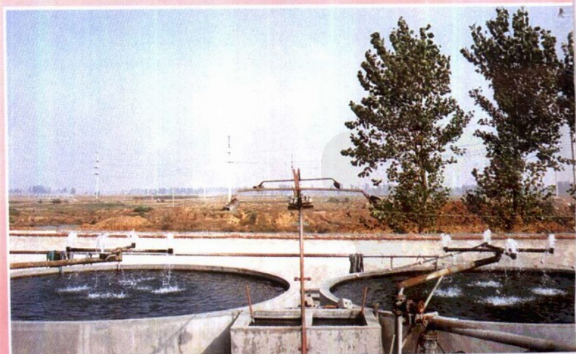
圆形并联式鱼 池进水喷头和 排水竖井
