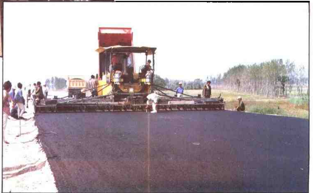
施工中的郑、汴、洛高速公路 赵一摄
