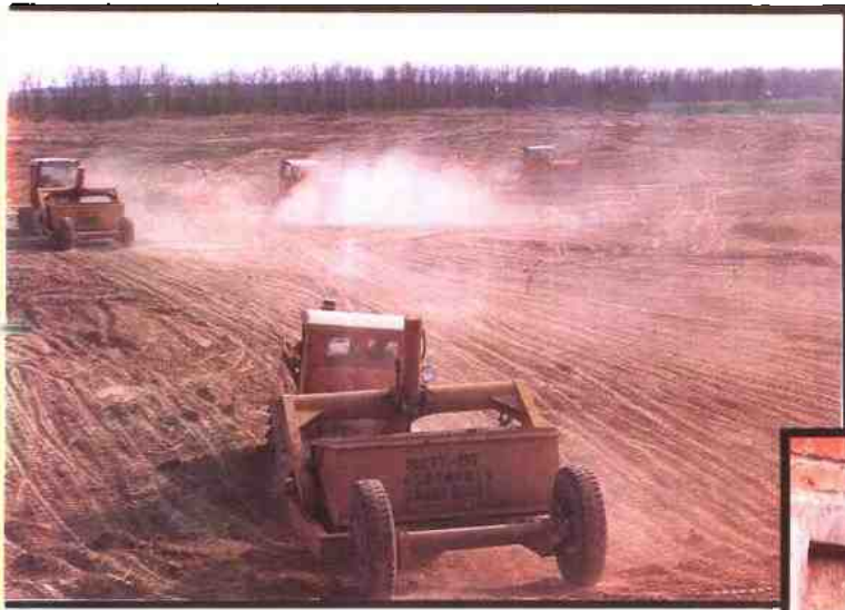
黄河大堤加固加高机械化施工现场 王刚法摄
