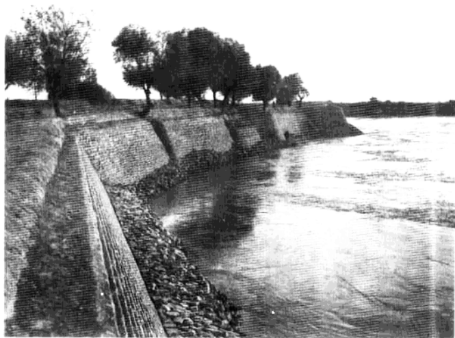
这是修好的大堤和建成的险工石坝——水上长城
