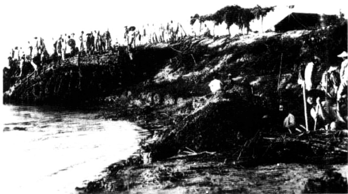
1948年7月山东高村抢险时坝堰被洪水冲走时的险情
