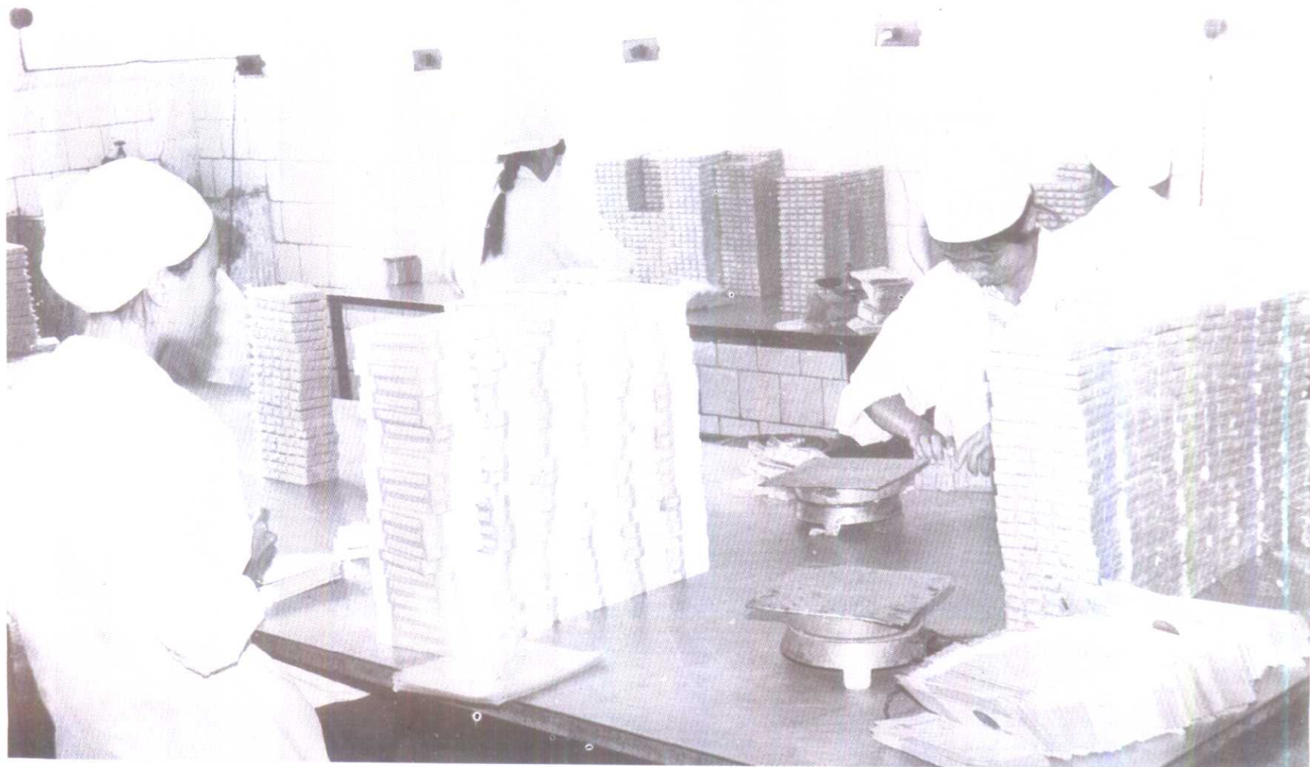
△县制药厂成品车间一角
