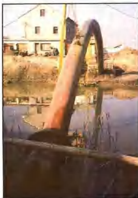
◁ 自来水『西水东调』二期工程八〇〇毫米铁管跨越长山解放河。(市城建局供稿)
