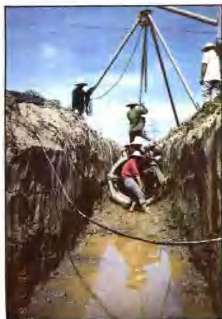
◁ 自来水『西水东调』一期工程九〇〇毫米管道施工现场。(市城建局供稿)
