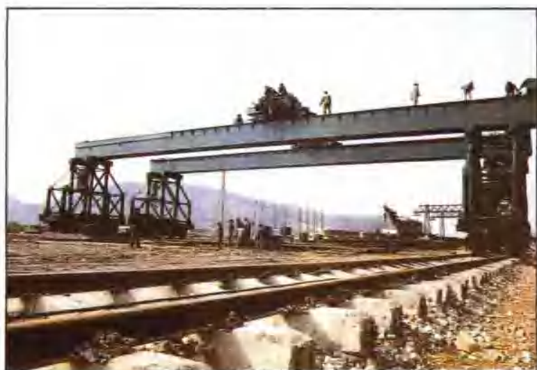
◁ 萧山境内连接钱江二桥的铁路正在紧张施工 ——。
