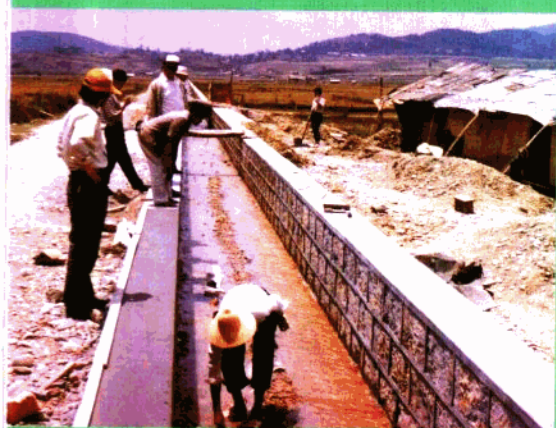
引水配套工程
