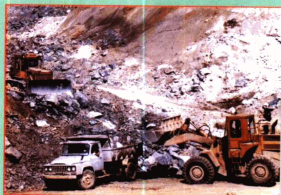
主厂房地基正在加紧作业
