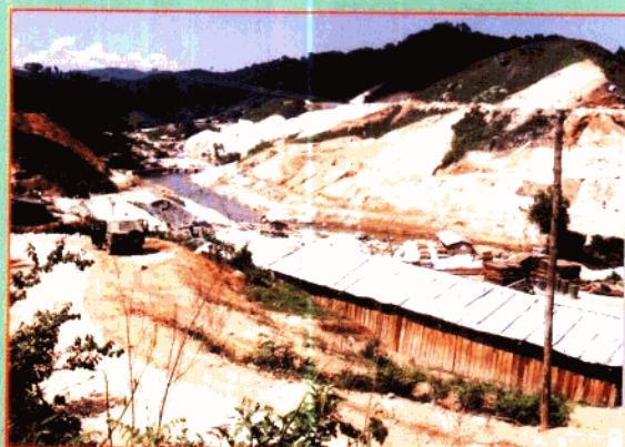
蓄水库大坝完成清基工程
