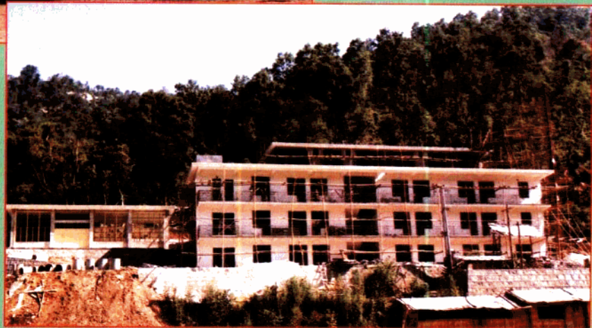
主廠房與大壩生活區加緊施工
