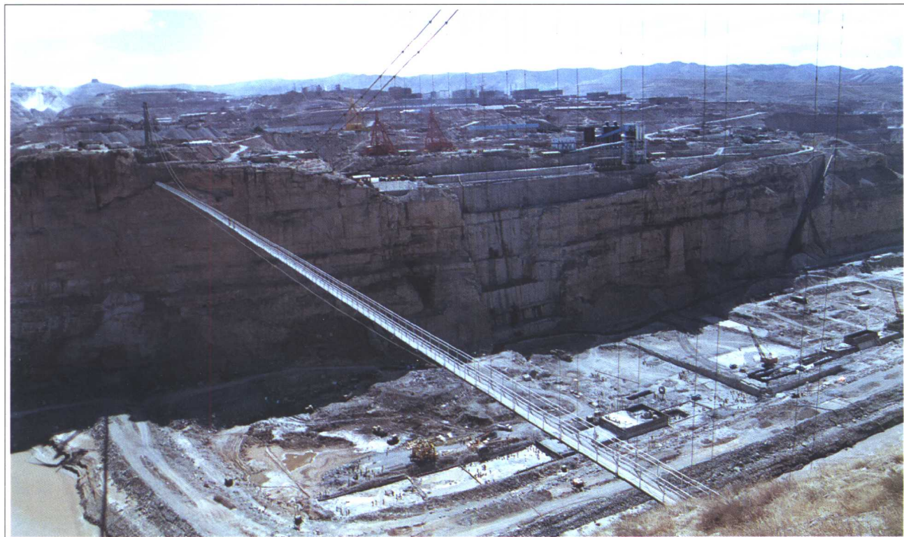
规模宏大的黄河万家寨水利枢纽工程正在施工中
