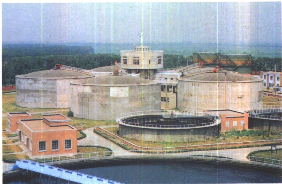
图5 消化池( 5 \times \phi 28.8\text{m} )
