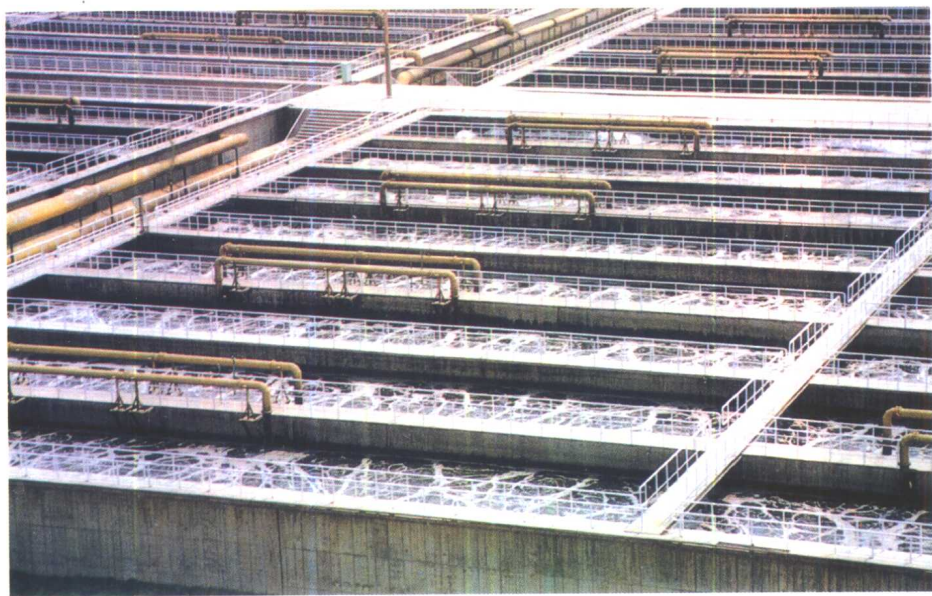
图6 曝气池( 60\text{m} \times 64\text{m} , 水深 5.2\text{m} )
