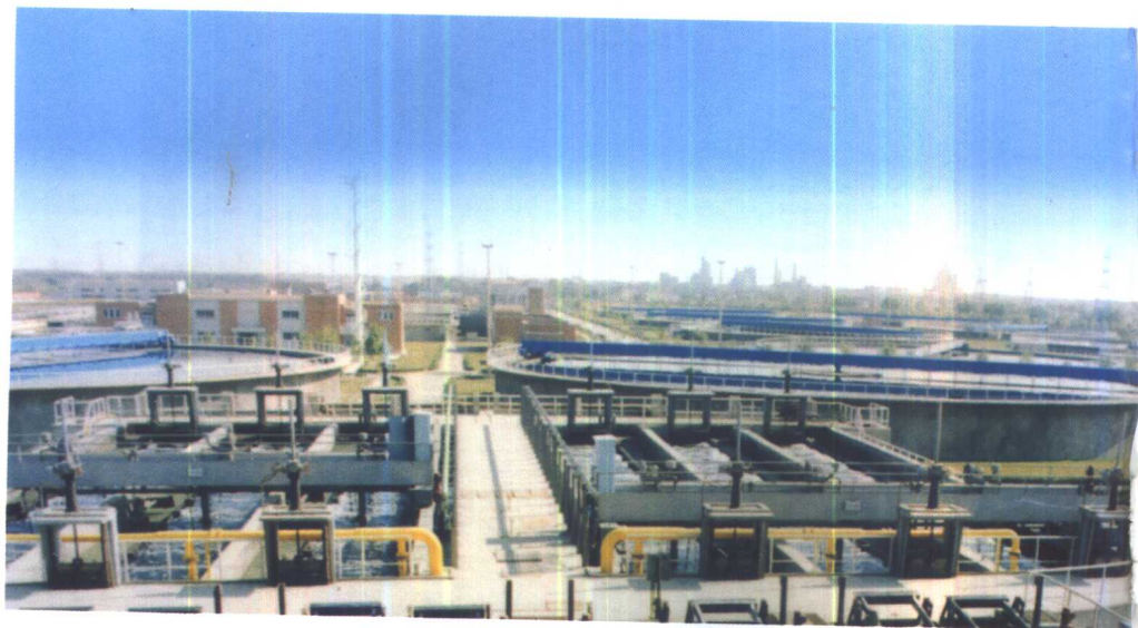
图4 有除浮渣功能的曝气沉砂池(文见114页)
