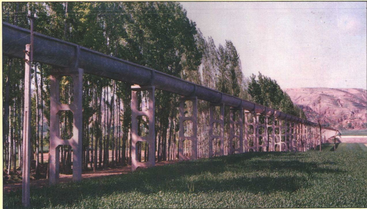
王村南水北调工程
