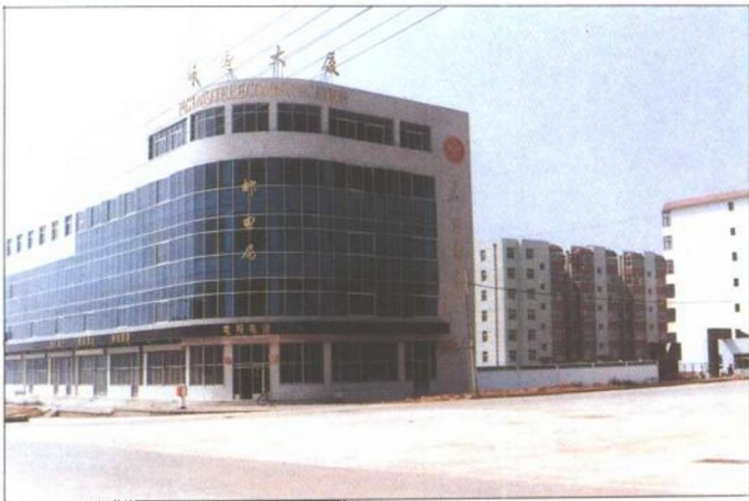
山海关经济技术开发区邮电大厦
