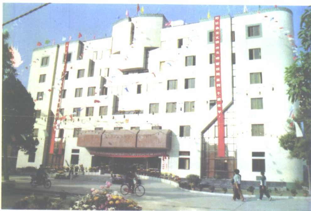
县政府办公大楼
